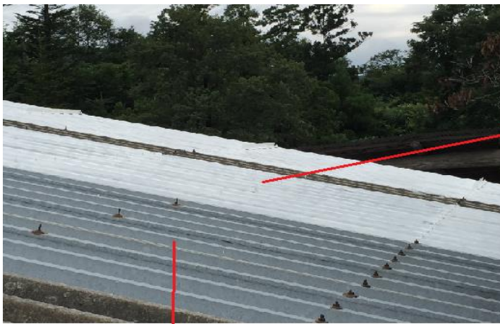
A 未塗装ガルバ波板部
